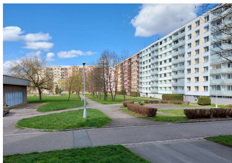
Obr. 4: Část sídliště v ulici Milady Horákové (19. 4. 2023)
