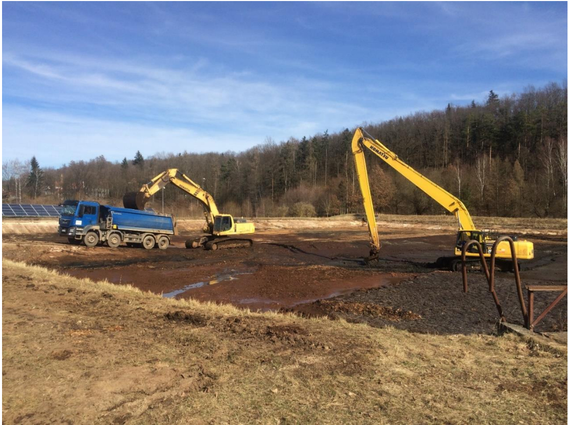
Obr. 1 Těžba a odvoz kalu z kalných lagun v katastrálním území zdroj: vlastní
