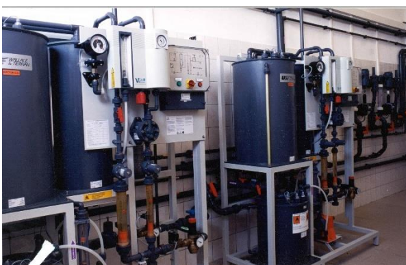
Zařízení pro přípravu ClO 2 (foto: Z. Antoš)
