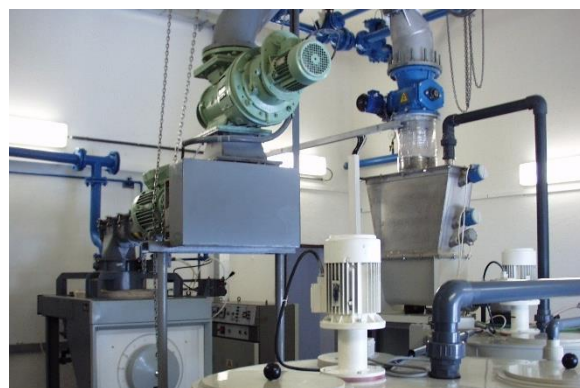
Zařízení pro přípravu vápenného mléka (foto: Z. Antoš)
