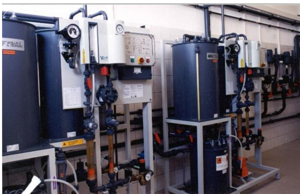
Zařízení pro přípravu ClO 2 (foto: Z. Antoš)
