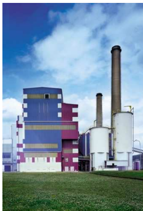
Obrázek č. 10 Elektrárna Poříčí
