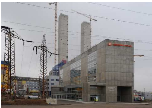
Obrázek č. 6 Elektrárna Ledvice
