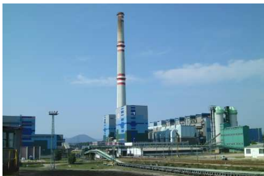
Obrázek č. 8 Elektrárna Pruněřov
