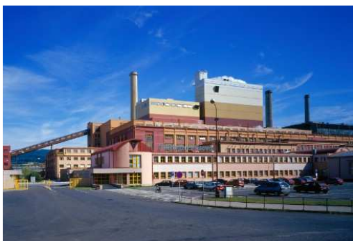
Obrázek č. 7 Elektrárna Tisová
