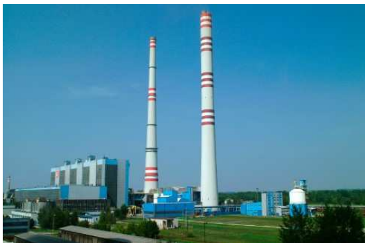
Obrázek č. 9 Elektrárna Dětmarovice
