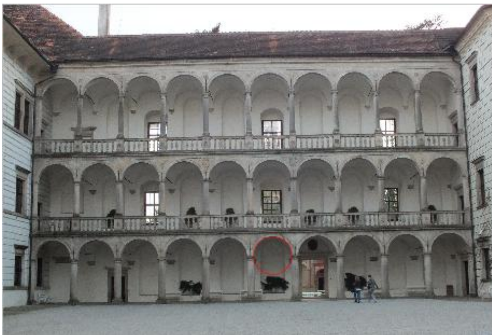
Obr. 18. Arkády na třetím nádvoří jindřichohradeckého zámku. Všechny oblouky tvoří půlkružnice. Červeně vyznačená kružnice téměř přesně překrývá jeden z kamenných oblouků. Rovnice červeně vyznačené kružnice má tvar: x^2+y^2=0,2 .
