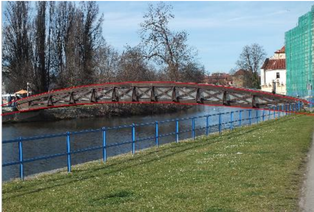
Obr. 15. Most s dřevěnou konstrukcí spojující Zátkovo nábřeží se Sokolským ostrovem. Horní mostní oblouk tvoří část elipsy a dolní mostní oblouk část hyperboly. Křivky byly identifikovány pomocí funkce „Kuželosečka daná pěti body“.
