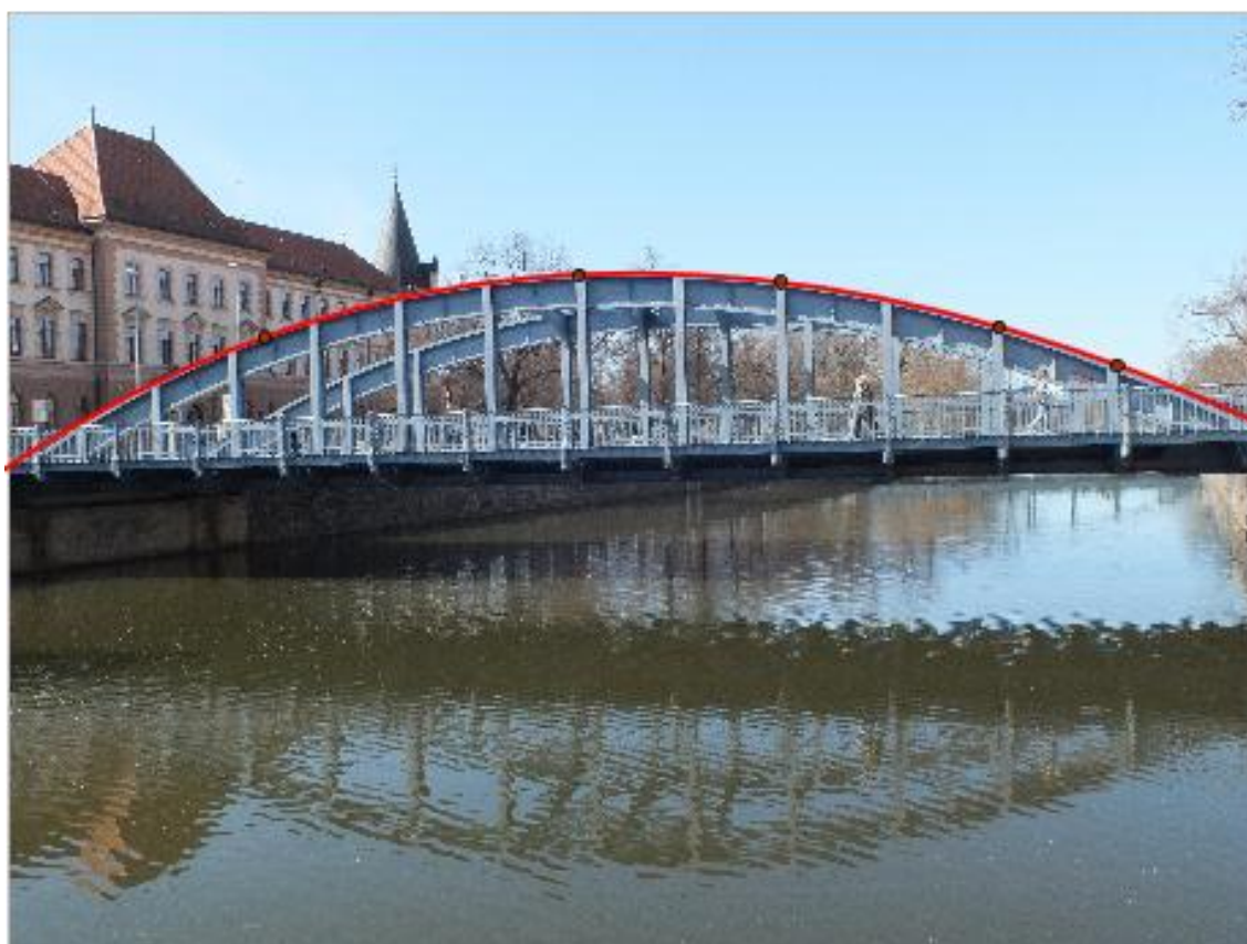
Obr. 3. Mostní oblouk proložený křivkou pomocí funkce „ Kuželosečka daná pěti body “.
