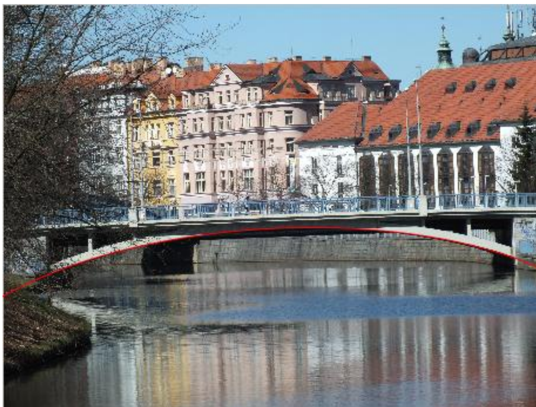
Obr. 14. Most přes Malši na Lidické třídě u Domu kultury Slávie. Mostní oblouk tvoří část elipsy. Identifikováno pomocí funkce „Kuželosečka daná pěti body“.
