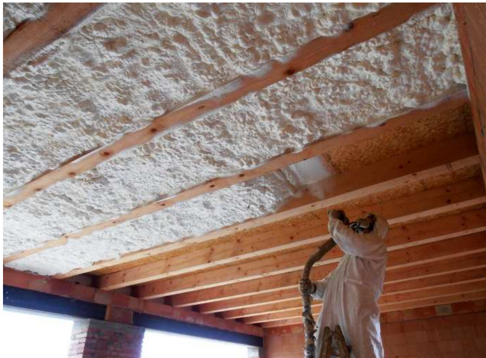
Obr. 14: Aplikace foukané izolace [18]
