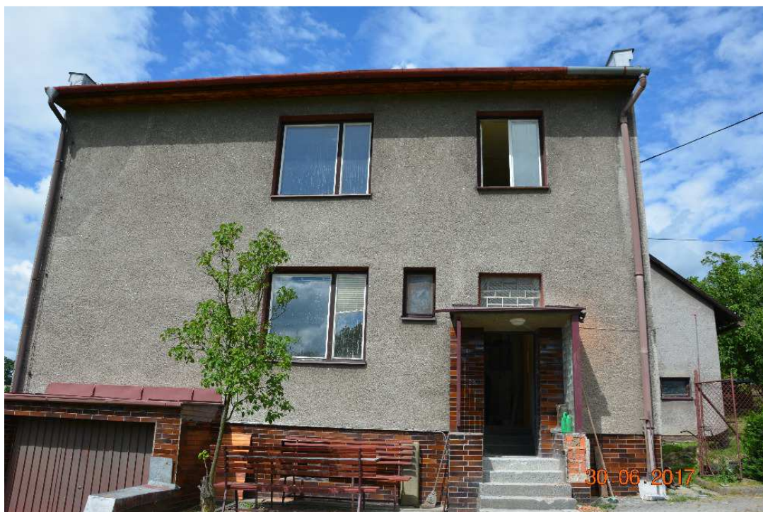
Obr. 20: Fotografický snímek posuzovaného rodinného domu
