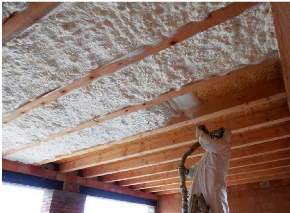
Obr. 14: Aplikace foukané izolace [18]
