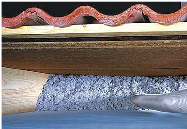
Obr. 3: Aplikace celulózové izolace foukáním [8]
