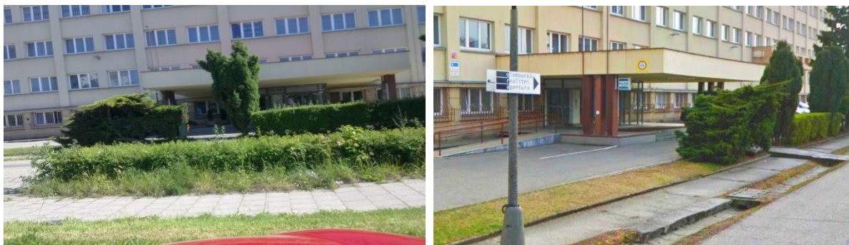
Obrázky 68, 69. Současný stav parkovacích podmínek pro jízdní kola u budovy Policie ČR (autor)
