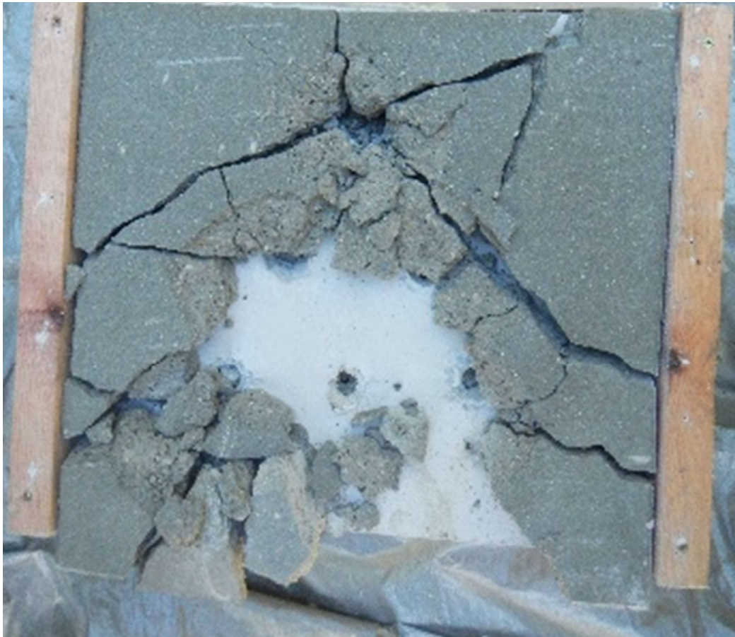
Obrázek 34 Skladba č. 1.2 TBO SG fragmentovaná vrstva betonu po demontáži sádkkartonu Foto: autor
