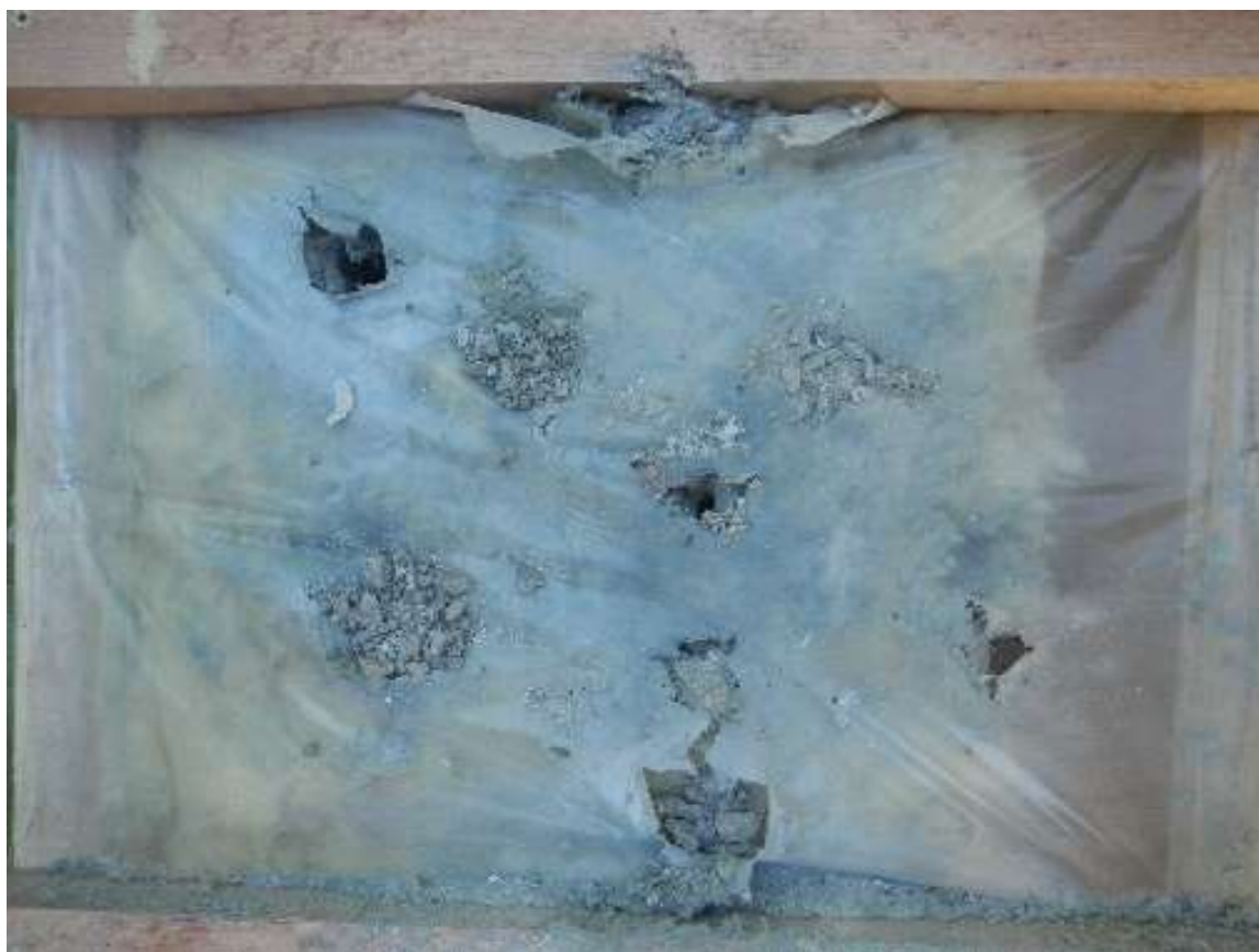
Obrázek 36 Skladba č. 1.3 TBO 7 CZ pohled na parotěsnou fólii po demontáži keramické dlažby Foto: autor
