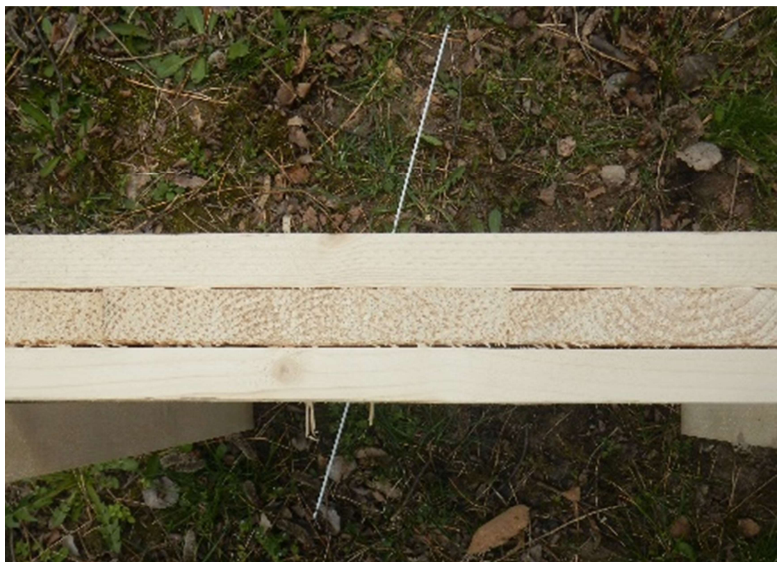
Obrázek 43 Skladba č. 3 TBO 4 CZ odklon střelného kanálu od kolmice v Dekpanelu. Foto: autor
