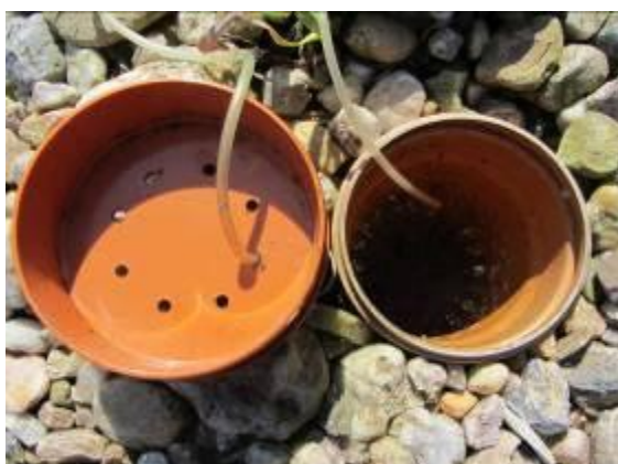
Obrázek č.9 - Přepad mezi filtračními komorami nádrže 1
