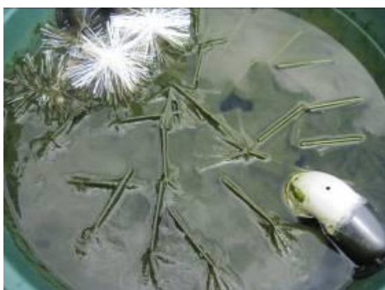
Obrázek č.19 - Kartáčová komora nádrže 2
