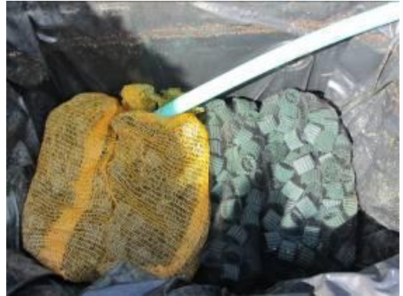
Obrázek č.12 - Čerpadlová šachta nádrže 1 s biobloky
