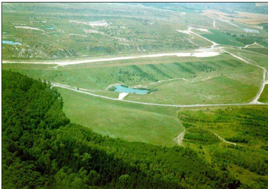
Obr. č. 9: rekultivace Radovesické výsypky (internetový zdroj 8)
