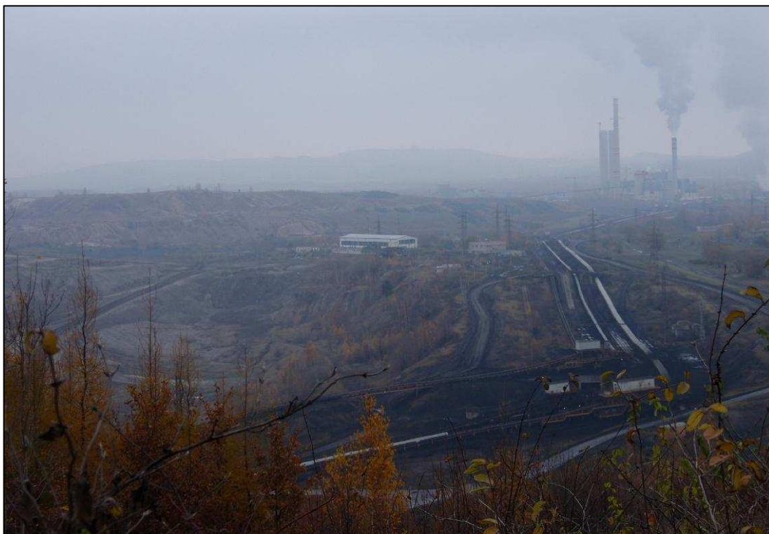
Obr. č. 11: pásové dopravníky vedoucí do Ledvické úpravny uhlí (Švejcar, 2009)
