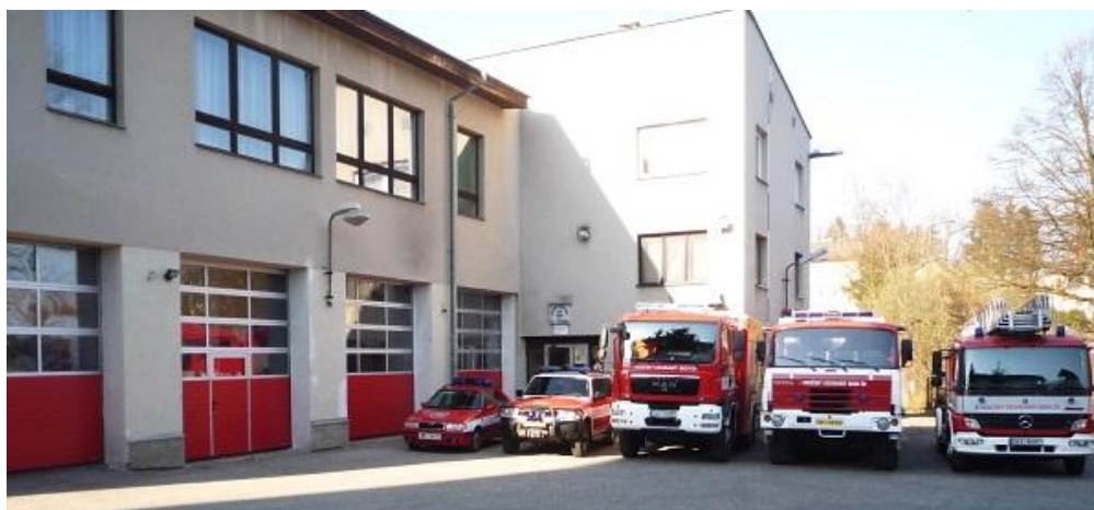
Obrázek 1: HZS Libereckého kraje, stanice Jilemnice
