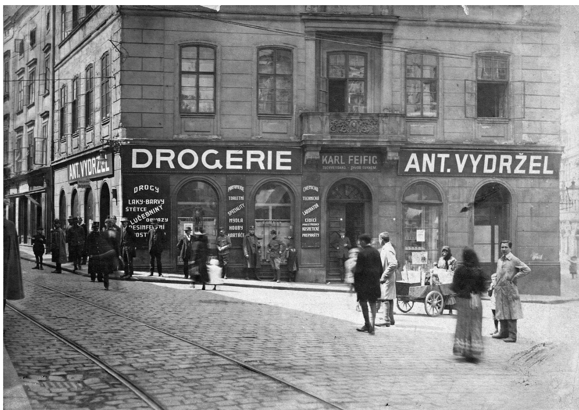
Obr. 21: Dům u Červené studny (Zdroj: jsemzolomouce.cz, 2021)
