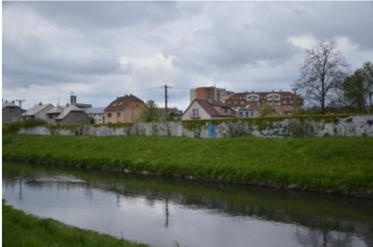
Obrázek 16 Protipovodňové zdi (vlastní foto)
