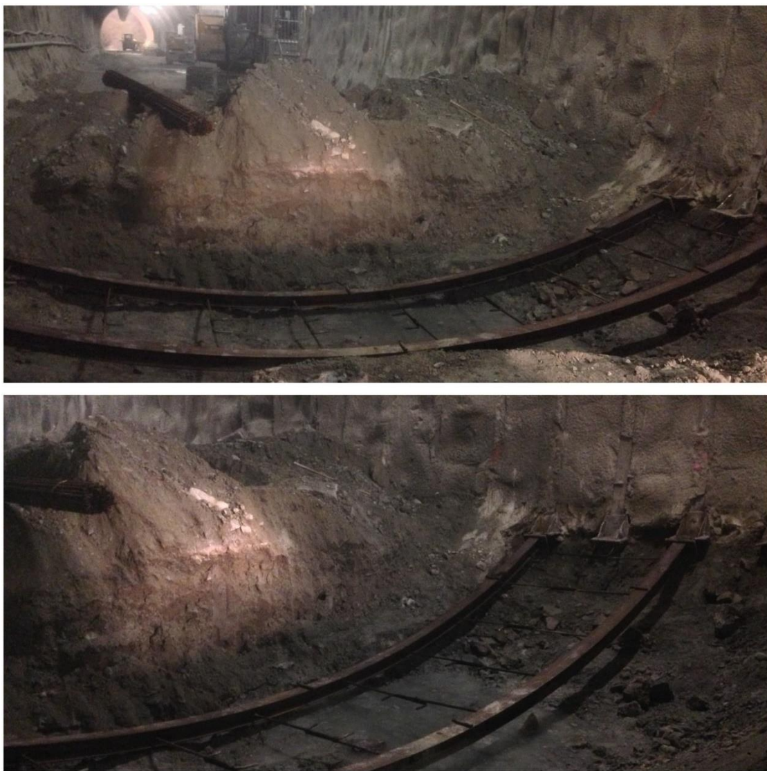
Obr. č. 46 a 47 – Inštalácia invertu v st. 22 346 – 22 355 v dňoch 15. – 20.3.2017
