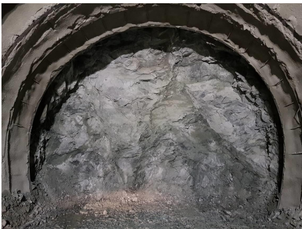
Obr. č. 57 – Dokumentácia čelby JTR, B01, st. 3495,55, dňa 20.1.2018 Čelba je sivými až tmavosivými biotitickými granodioritmi.
