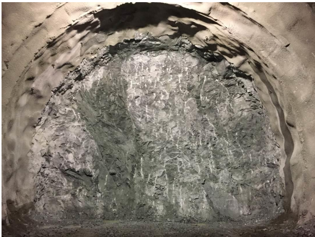
Obr. č. 56 – Dokumentácia čelby JTR, A1/1, st. 3486,18, dňa 16.1.2018. Čelba je budovaná sivými až tmavosivými biotitickými granodioritmi.
