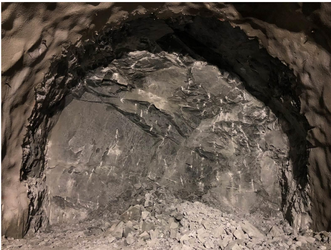
Obr. č. 52 - Dokumentácia čelby JTR, A1/1, st. 3 604,90 dňa 5.3.2018 Čelba je budovaná sivými až tmavosivými biotitickými granodioritmi, lokálne mylonitizovanými granodioritmi a blastomylonitmi
