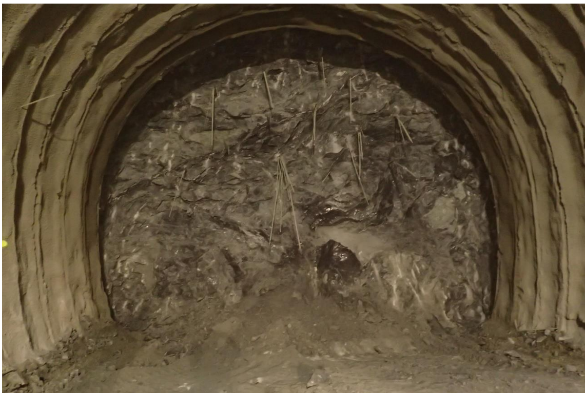
Obr. č. 43 – Dokumentácia čelby STR, B03, st. 22 344, dňa 23.12.2016 Čelba je budovaná čiernastými blastomylonitmi s prechodom do sivých mylonitizovaných granitoidov, väčšinou s grafitovo – ílovitou výplňou.
