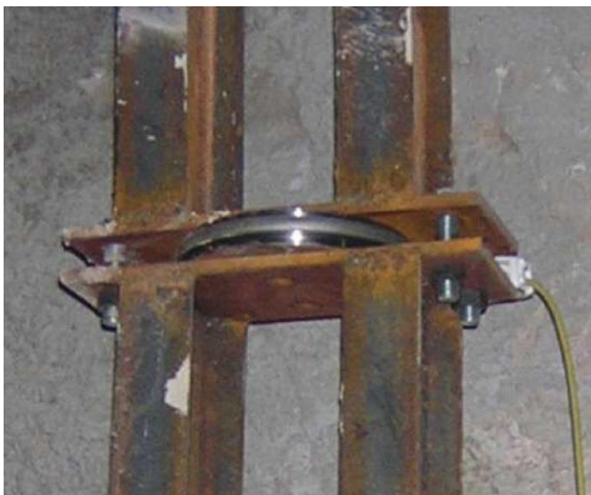
Obr. č. 19 - Tlakové podušky umiestnené na stykoch oceľových skruží [9]
