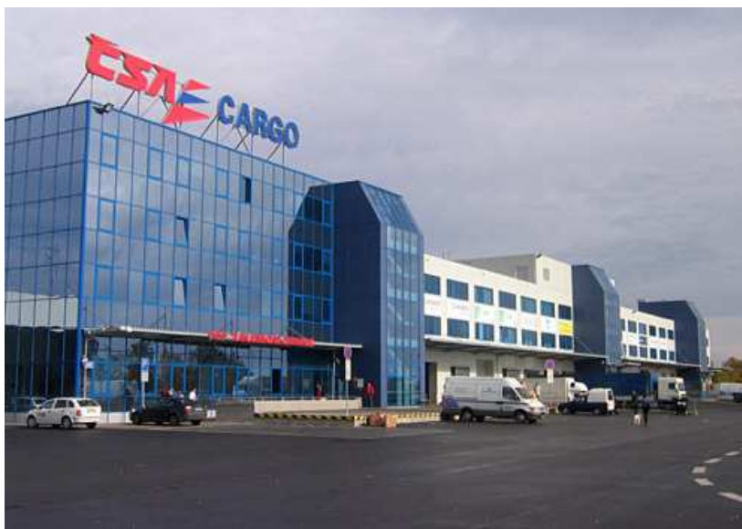
Obrázek 9 Cargo terminál Praha - Ruzyně [18]
