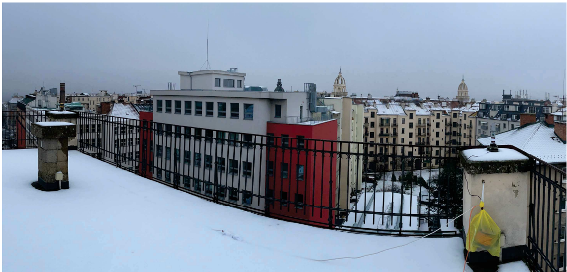
Obrázek 17: Fotografie pilířů na budově VUT v Brně
