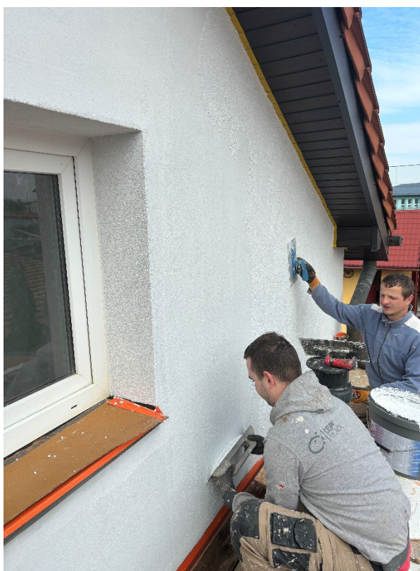
Obr. 15 Aplikácia tenkovrstvej omietky [zdroj: autor]
