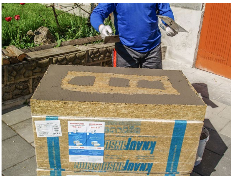
Obr. 7 Penetrácia tenkou vrstvou lepidla [2]
