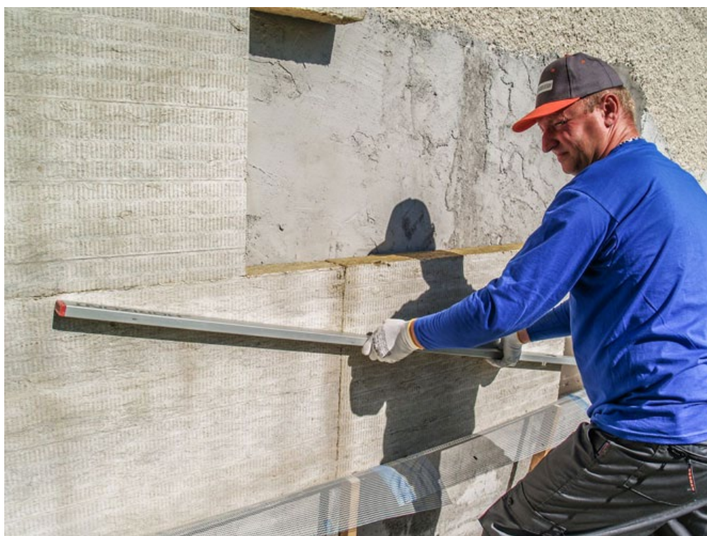
Obr. 9 Osadenie dosiek z minerálnej vaty [2]
