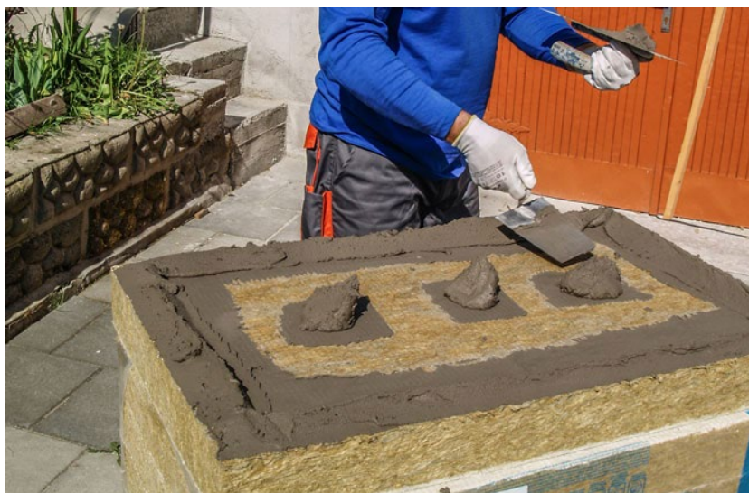
Obr. 8 Nanesenie lepidla na izolant [2]
