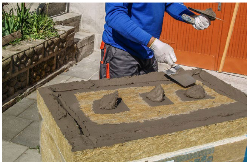
Obr. 8 Nanesenie lepidla na izolant [2]
