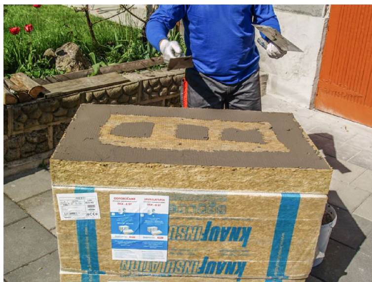
Obr. 7 Penetrácia tenkou vrstvou lepidla [2]
