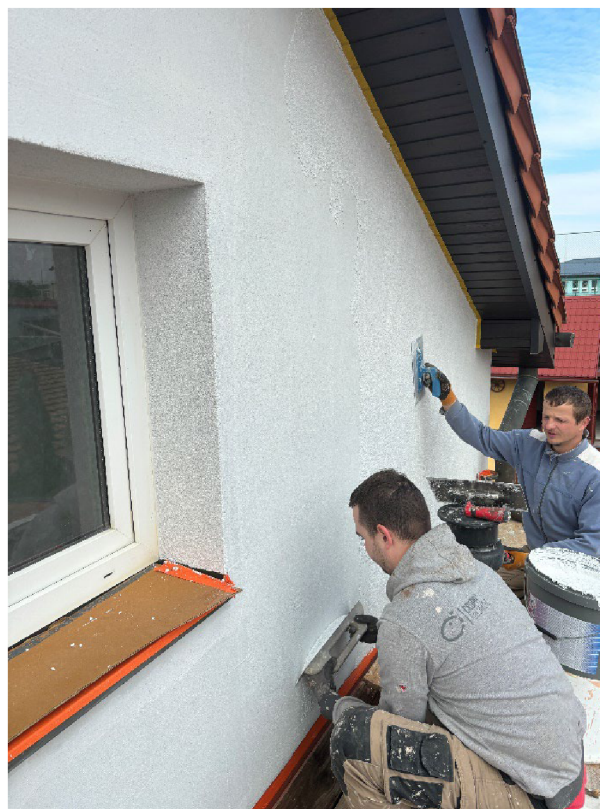
Obr. 15 Aplikácia tenkovrstvej omietky [zdroj: autor]
