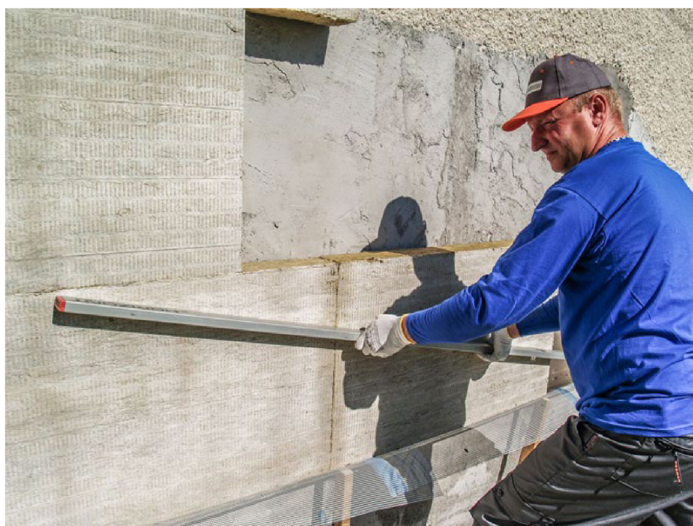
Obr. 9 Osadenie dosiek z minerálnej vaty [2]
