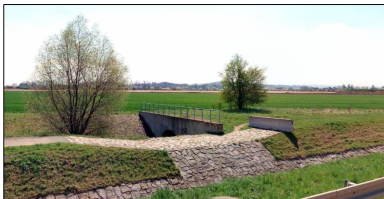
Obr. 28) Vtok do zatrubněné části toku [9]
