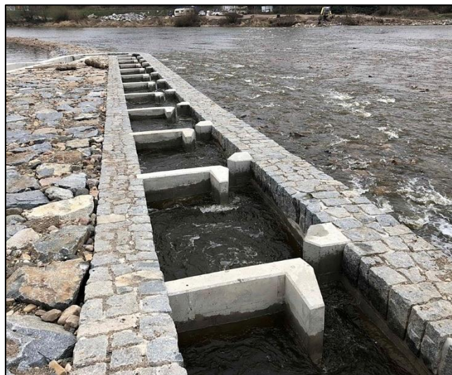
Obr. 12) Technický rybí přechod – štěrbinový [16]
