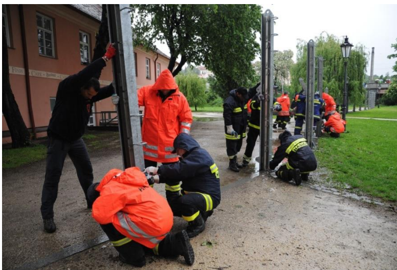
Obrázek 13: Hasičský záchranný sbor ČR při výstavbě protipovodňových opatření ( https://bezpecnost.praha.eu/ )
