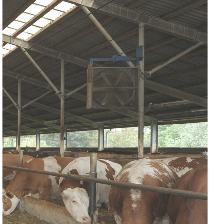
Obrázek 5: Detail větráku a evaporačního zařízení v Havlíčkově Borové
