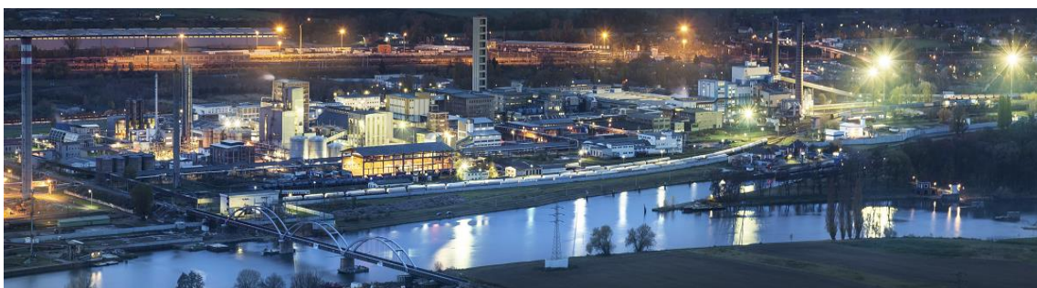
Obrázek 3: Areál Lovochemie, a.s., Lovosice (Zdroj: Lovochemie.cz, 2024)
