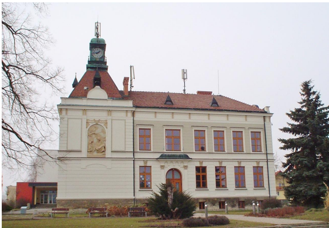
Historická část budovy školy v roce 2015 (foto autor)
