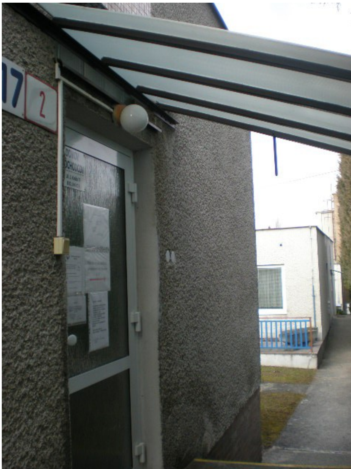
Obrázok č. 6: Vstup do domova dôchodcov Bojnice
