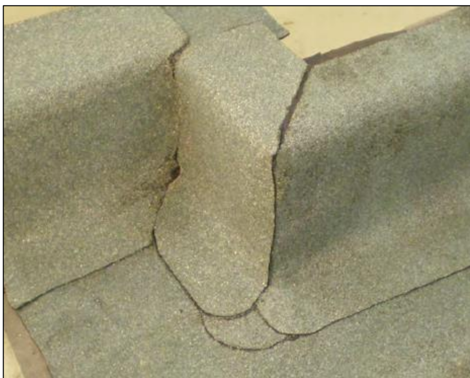
Obrázek 56: Vnější a vnitřní rohy s univerzálními tvarovkami - 2. vrstva
