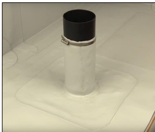
Obrázek 71: Prostup - dokončení
