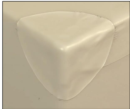
Obrázek 66: Vnější horní roh atiky
