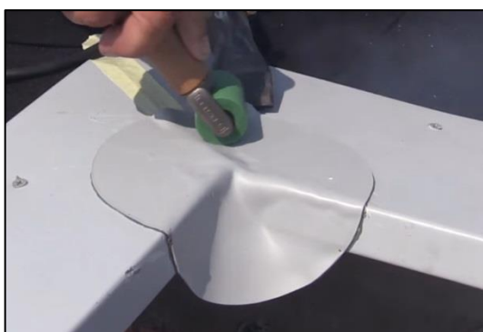
Obrázek 58: Okapnice - dilatace v rozích
