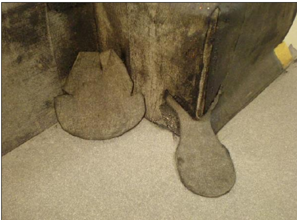
Obrázek 57: Vnější a vnitřní rohy s univerzálními tvarovkami - 1. vrstva
