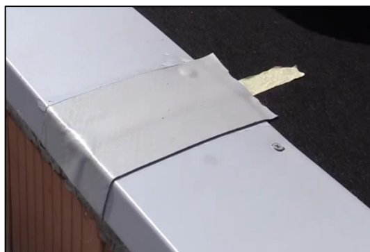
Obrázek 59: Okapnice - přeplátování dilatace
