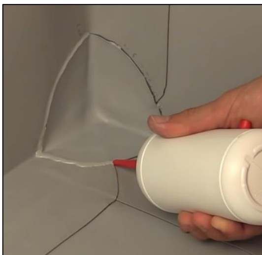
Obrázek 68: Aplikace pojistné zálivky
