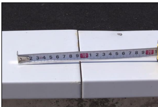
Obrázek 60: Okapnice - dilatační mezera
