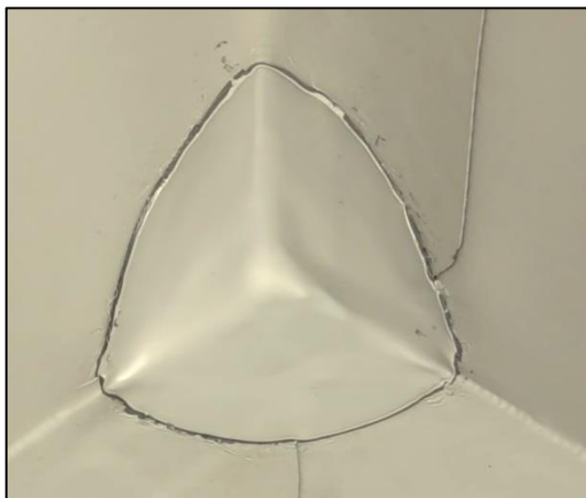
Obrázek 64: Vnitřní dolní roh atiky
