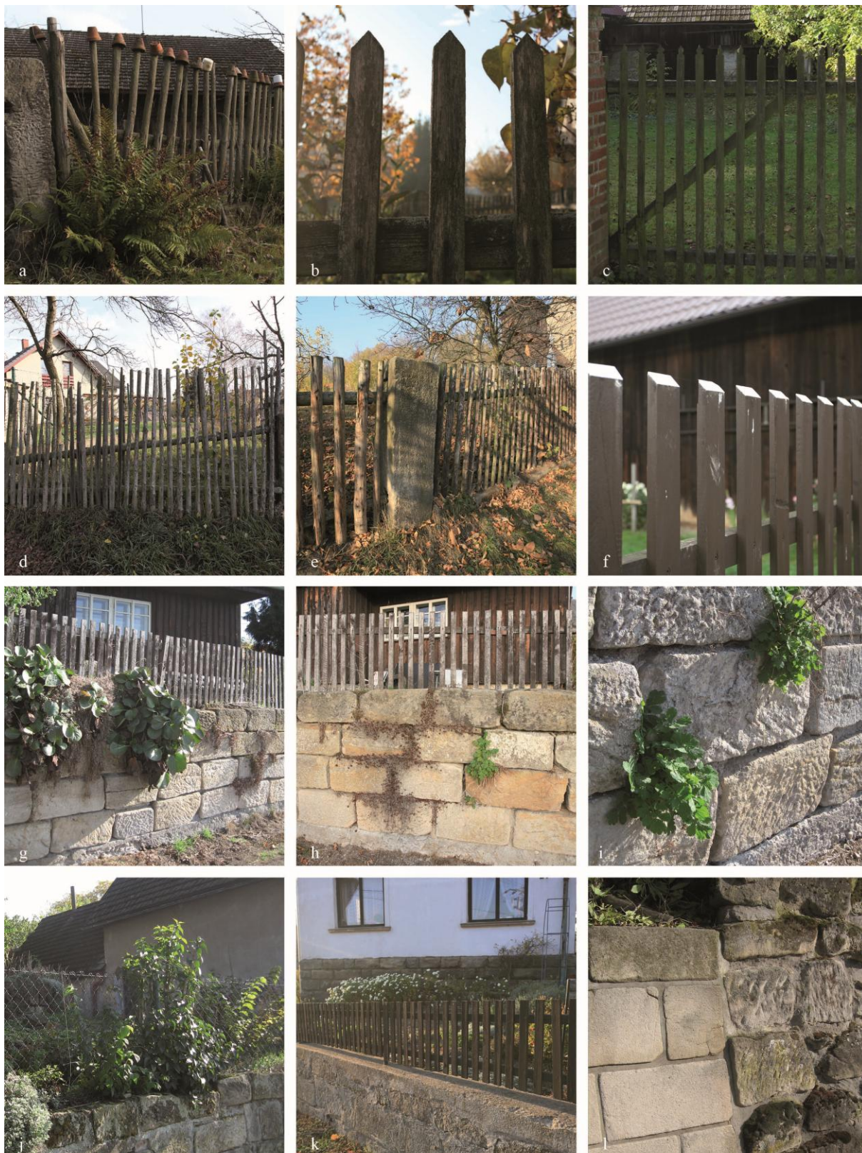
Obrázek 43: Plaňkové dřevěné ploty (Zdroj: autor)
