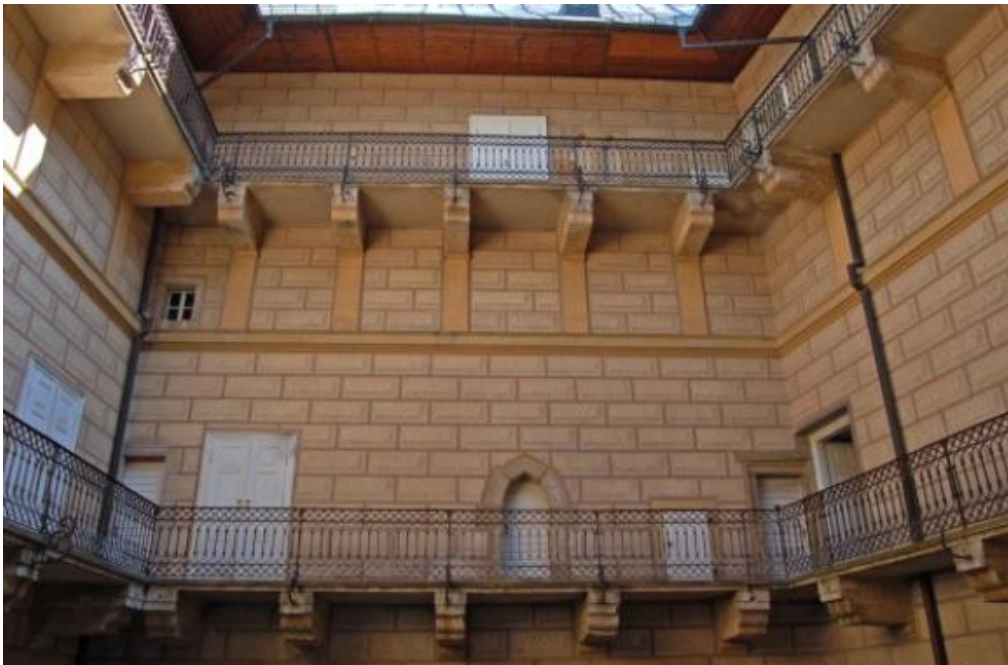
Obr. 28 Vnitřní nádvoří hradu Houska
