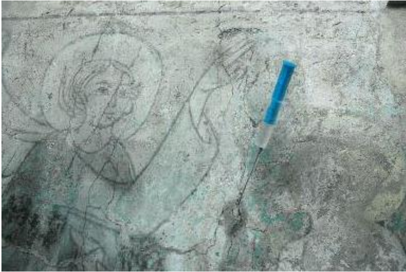
Obr. 25 Upevňování a injektáže – kaple
