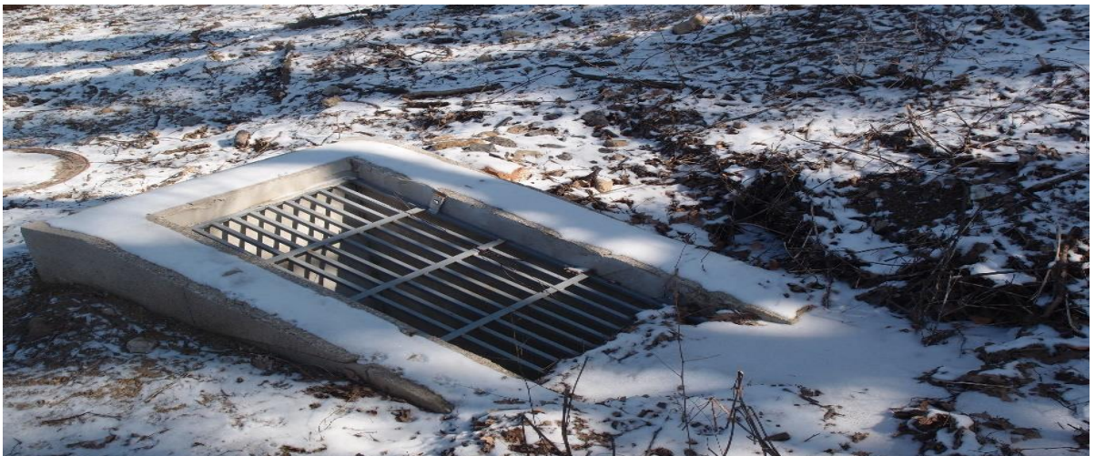
Obrázek č. 8: Přímé odvodňovací žebro v k.ú. Kaceřov po realizaci (Vejsadová ©2023)
