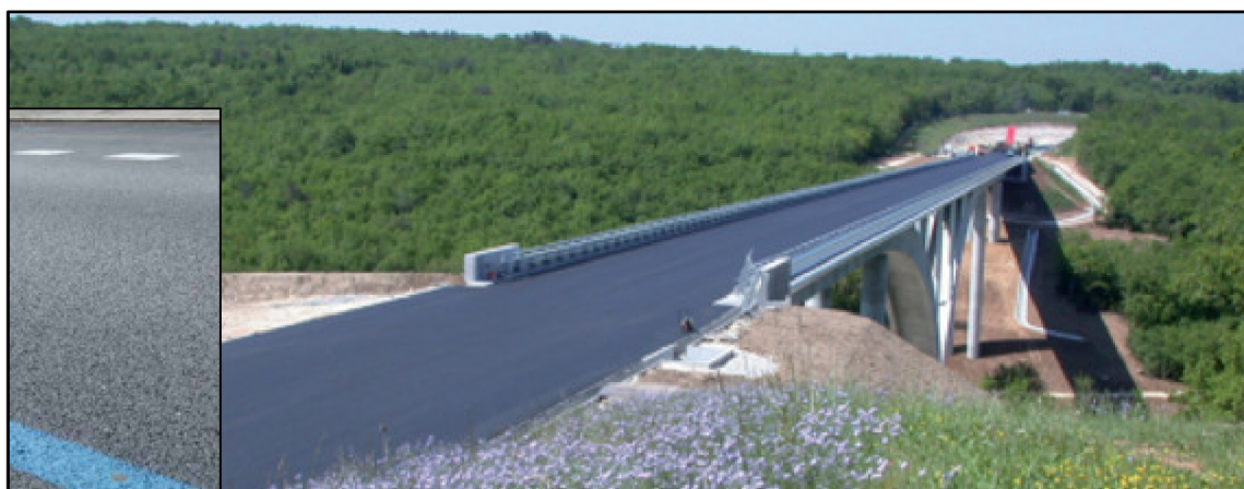
Obrázek 11: Aplikace směsi VIAPHONE [12]
