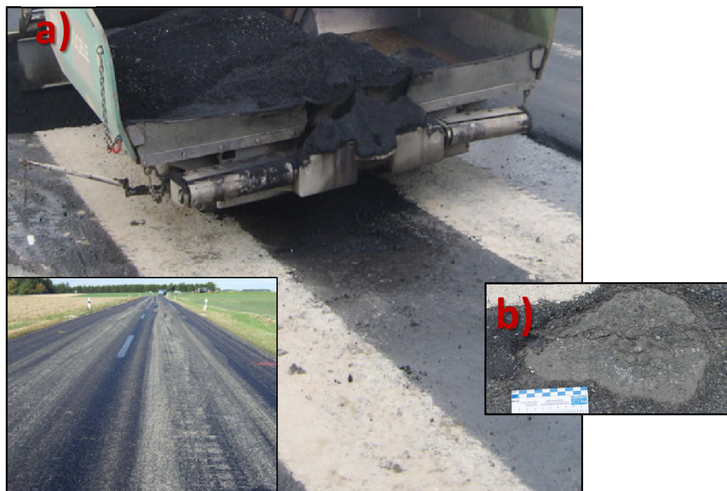
Obrázek 6: a) Ukázka běžné situace (odstraněné emulze koly) při pokládce b) Výtluk [8]
