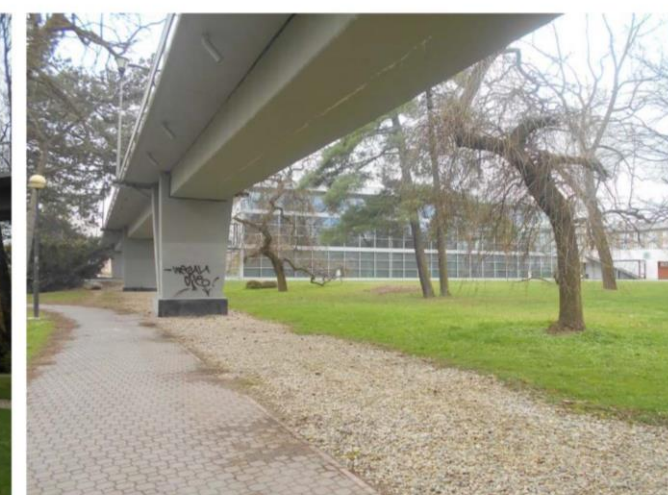
Obr. 102 – Vzdálenější pohled do místa s Vodní zahradou. Převíslé kultivary Sophora japonica by vytvářely zajímavou harmonii s horizontální vodou (foto: L. Řiháčková).
