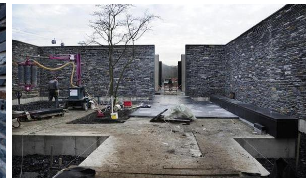
Obr. 93 – Probíhající výstavba části vodní zahrady (Tagesspiegel).
