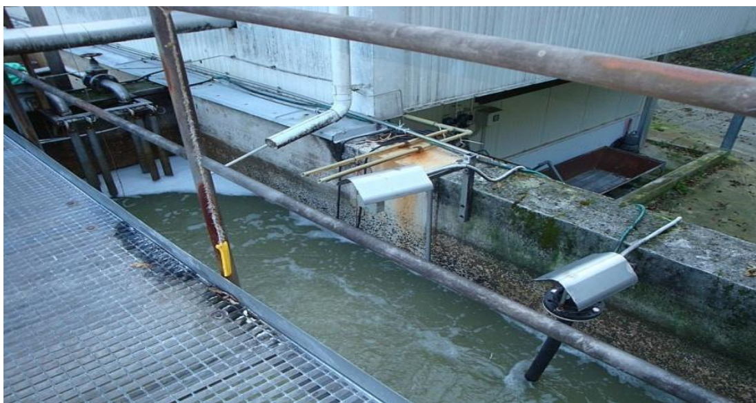
Obr. 4.3 - Čerpací a neutralizační jímka (zdroj: vlastní foto)
