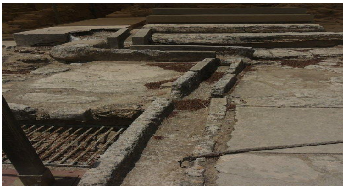
Obr. 3.1 – Odpadní kanály na Krétě – Knóssos
