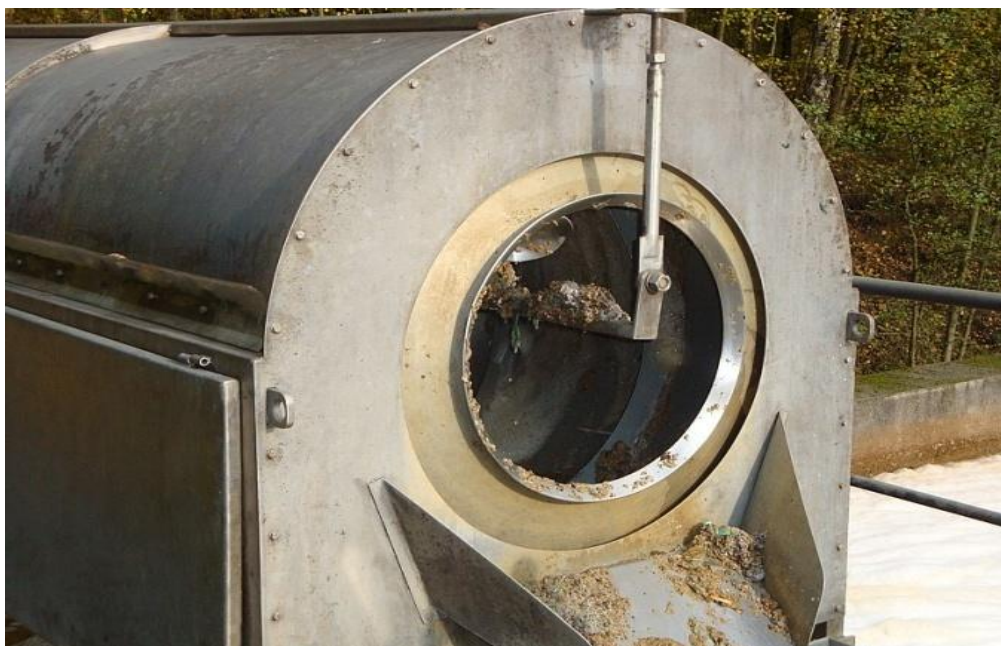
Obr. 4.1 - Rotační mikrosíto TB 800 (zdroj: vlastní foto)
