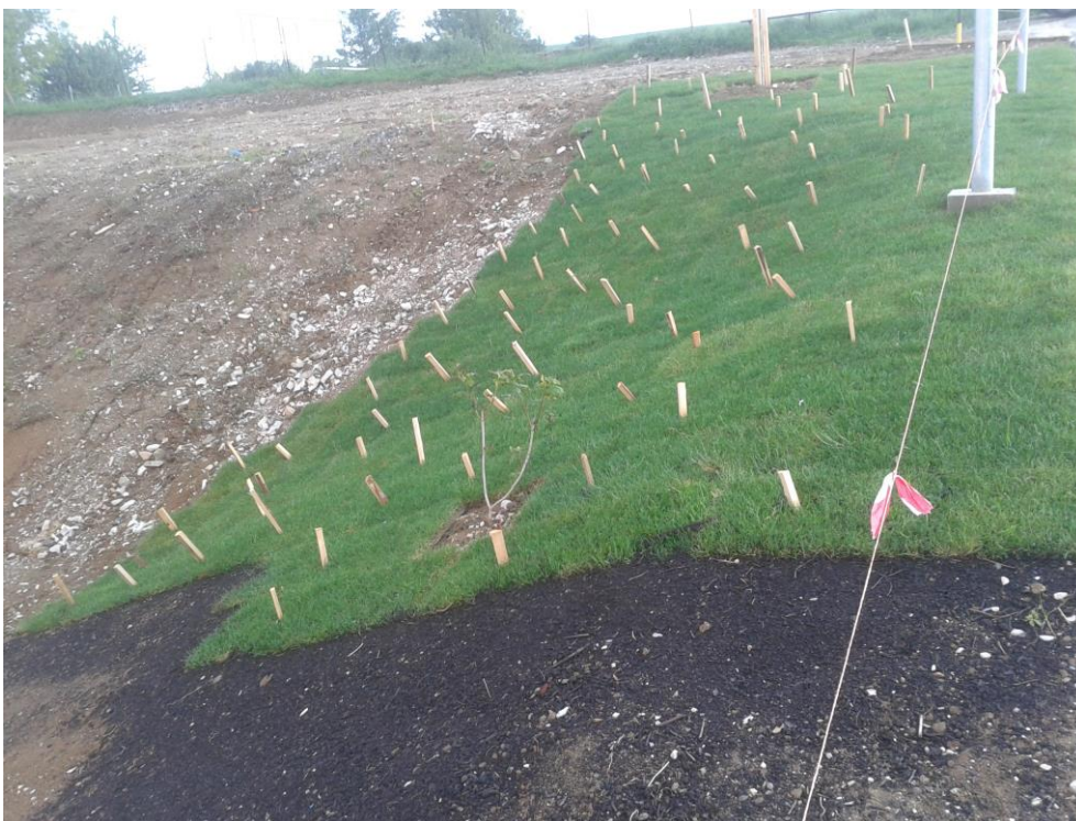
Obr. č. 4 Zakladanie trávniku predpestovanými trávnymi drnmi na svahu so zaistením drevenými kolíkmi proti zosuvu (Vašík, 2014)
