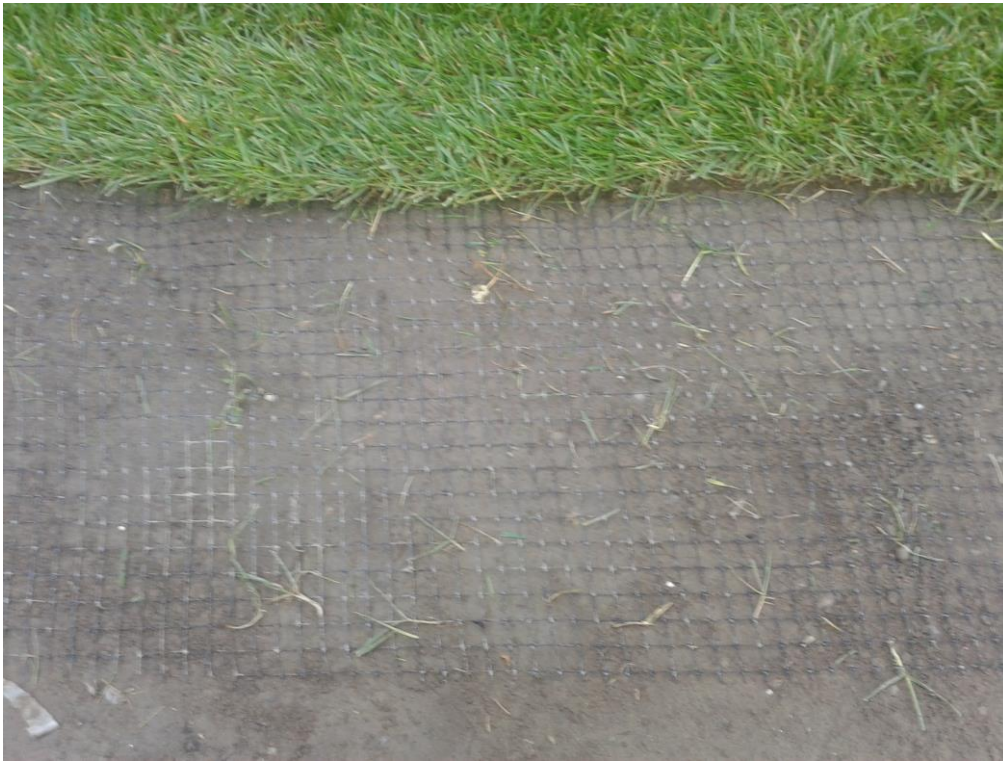
Obr. č. 3 Zakladanie trávniku predpestovanými trávnymi drnmi so sieťou proti krtom (Vašík, 2012)
