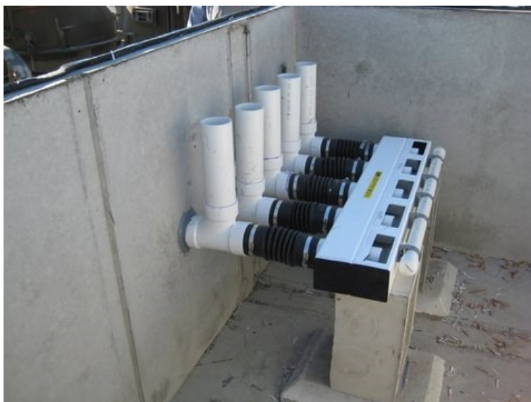
Obr. 5 Sériově zapojení MultiFlout [18]
