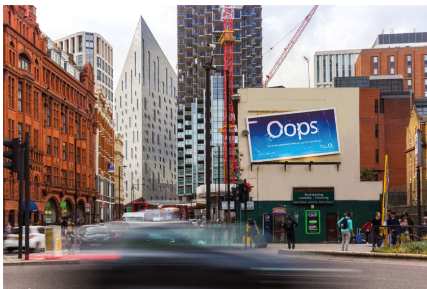
Obrázek 22. Billboard umístěný na průčelí rekonstruované budovy, který jako by rozbily jeřáby během rekonstrukce. (zdroj: https://www.clearchannel.co.uk/latest/o2-and-award-winning-out-of-home )
