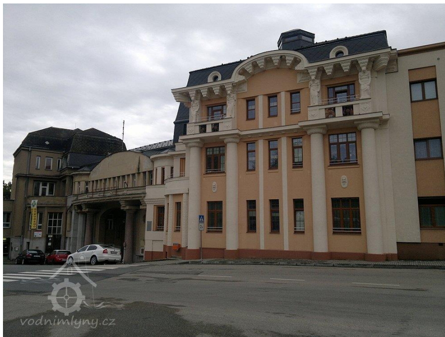
11. Průčelí bývalé borovinské továrny, na jejímž místě stával Borovinský mlýn.
