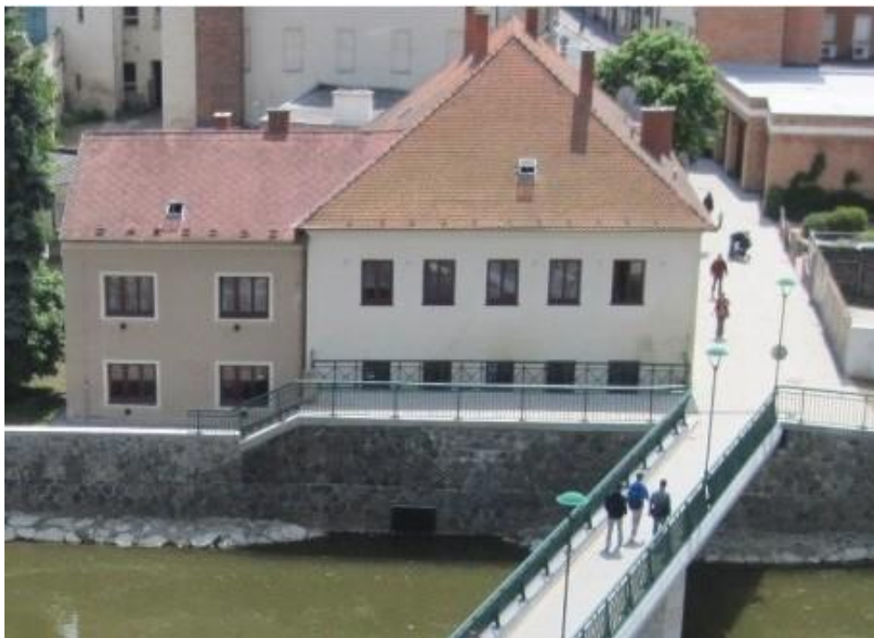
3. Rohová budova u mostu – bývalá soukenická valcha
