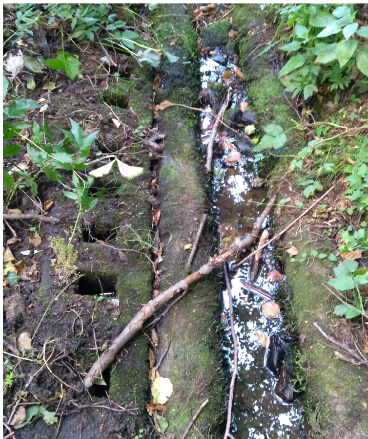
Obrázek 8: Technicky opevněné koryto Chynského potoka.
