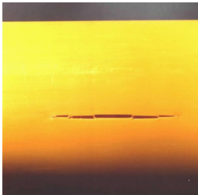
Obr. 1.6: Kvazi-křehké porušení polyethylenové trubky [22]
