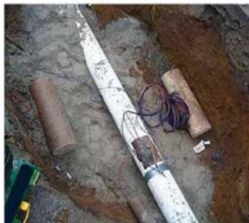
Obr. 3: Katodická ochrana potrubí [2]
