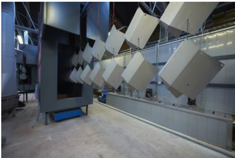
Obr. 18: Tunelová pec s díly [15]
