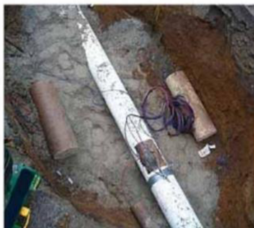
Obr. 3: Katodická ochrana potrubí [2]
