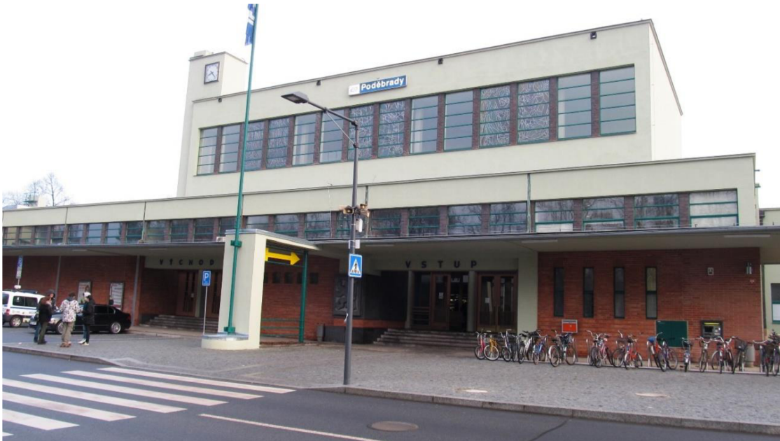
Obr.č.26, Nádražní budova . zdroj: https://region.rozhlas.cz/budova-nadrazi-v-podebradech-ma-tvar-lokomotivy-oprava-stala-33-milionu-korun-7255520
