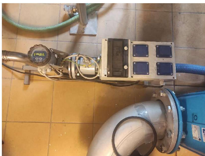
Obrázek 14 Elektromagnetický indukční průtokoměr DN50
