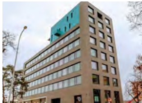
ADMINISTRATIVNÍ BUDOVA ČESKÝCH PŘÍSTAVŮ
