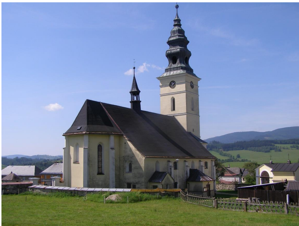
49. obr.: Staré Město pod Sněžníkem, farní kostel sv. Anny, po 1584, pohled od severovýchodu.
