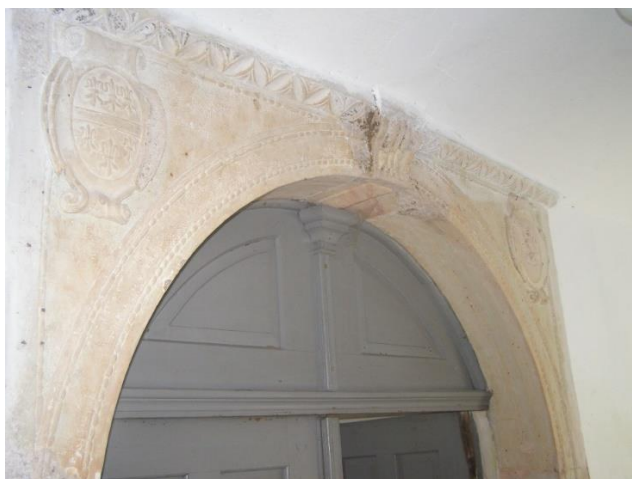
22. obr.: Branná (Kolštejn), boční vstupní portál do kostela, 1614.
