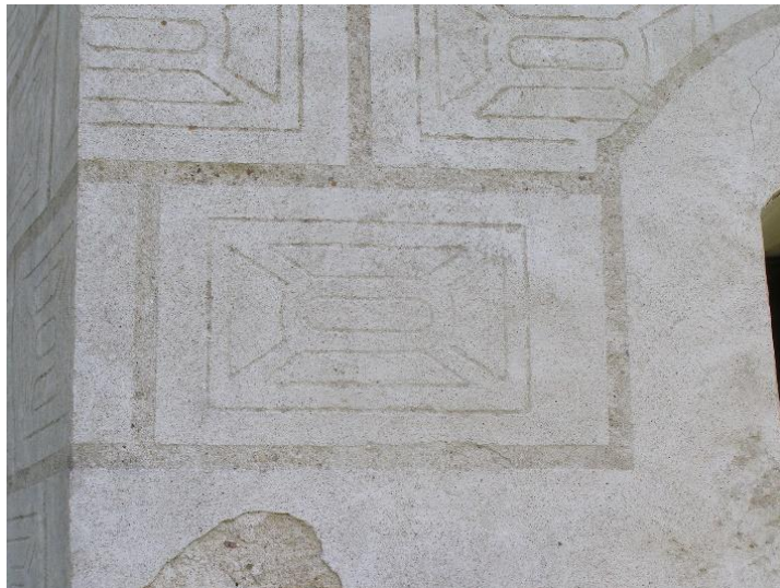
44. obr.: Kunčice, renesanční kaple (zvonice), detail zrestaurovaných sgrafit, 80.léta 20. století (původní 90. léta 16. století).
