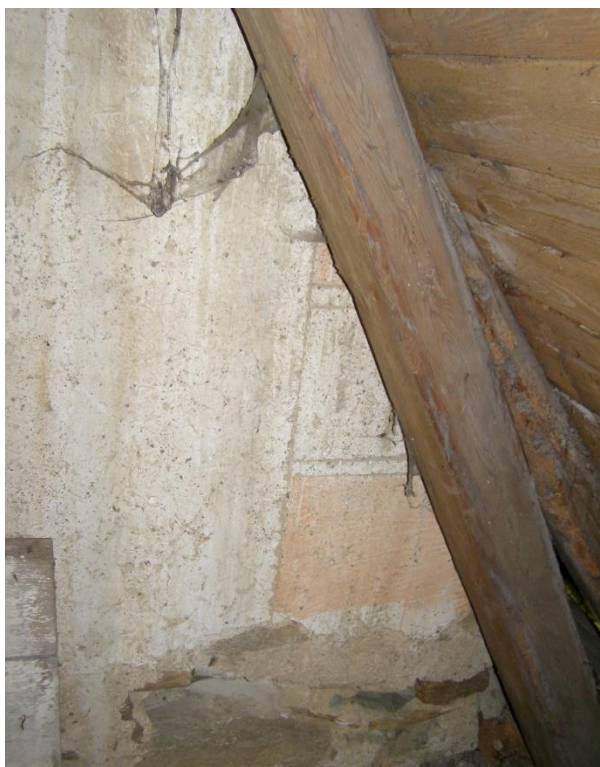
70. obr.: Vikantice, filiální kostel sv. Volfanga, armování stěny zvonice v podkroví, před 1611.
