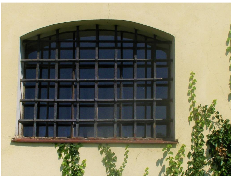
65. obr.: Kovaná mříž okna lodi, po 1584, Staré Město pod Sněžníkem, farní kostel sv. Anny.
