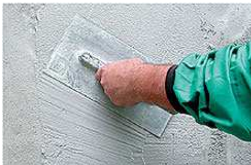
Obr. 7.3.3: nanášení omítky
