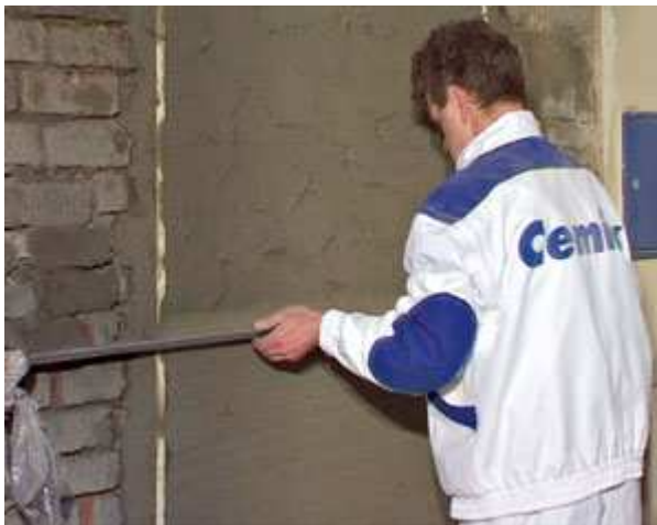
Obr. 7.3.2: provádění podhozu
