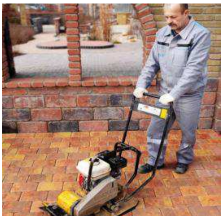
Obr. 7.4.3: vibrační zpevňování
