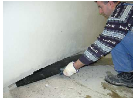
Obr. 7.1.4: vkládání hydroizolace
