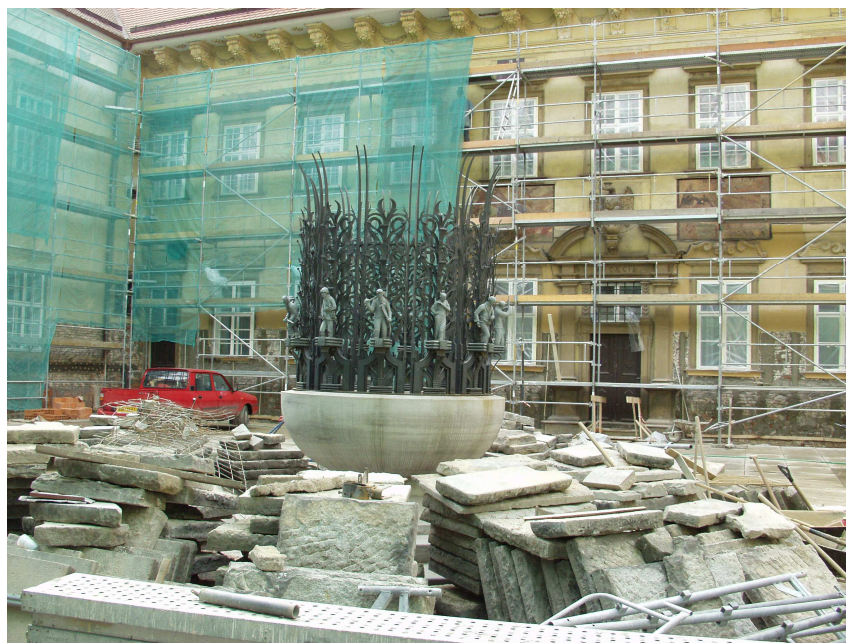
Obr.1.5. pův. stav nádvoří
