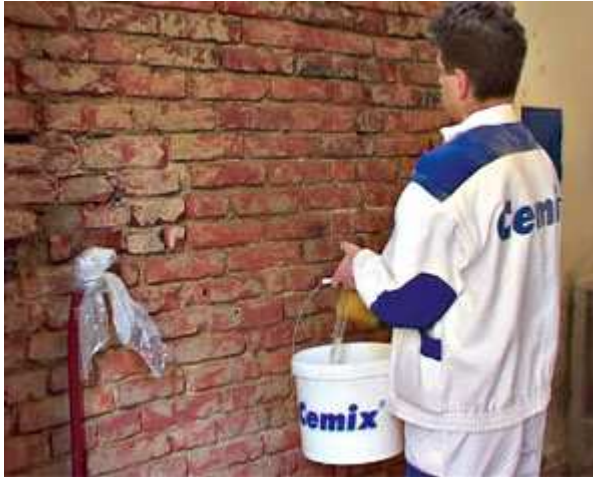
Obr. 7.3.1: očištění konstrukce
