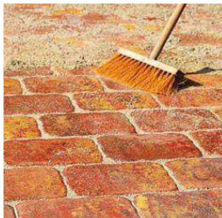
Obr. 7.4.4: spárování
