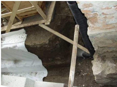
Obr. 2.2: geotextília
