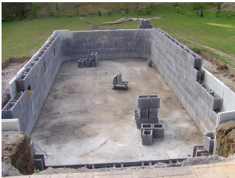
Obrázek 21 – Bazén ze ztraceného bednění [26]
