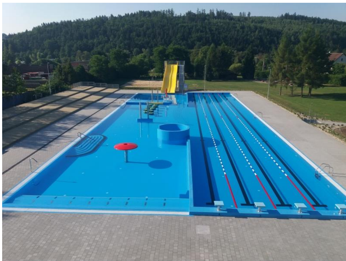
Obrázek 36 – Konečná podoba rekonstrukce venkovního bazénu bazén léto 2017 [32]
