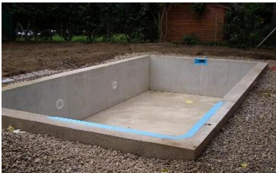
Obrázek 18 – Bazén z betonu [23]
