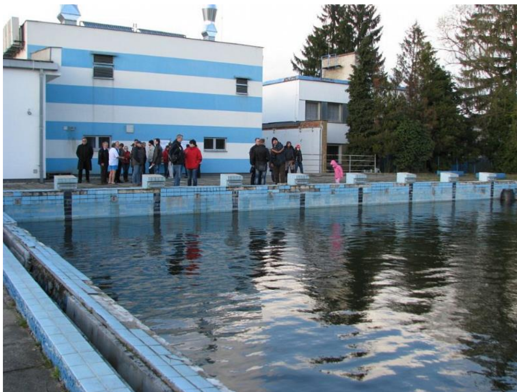
Obrázek 35 – Havarijní stav venkovního bazénu stav před rekonstrukcí [33]
