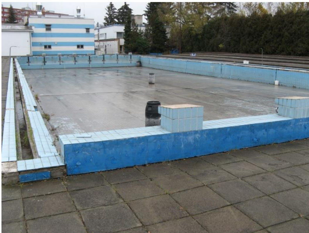
Obrázek 34 – Původní venkovní bazén stav před rekonstrukcí [32]
