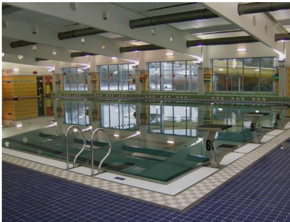
Obrázek 30 – Vnitřní krytý bazén Zábřeh stav podzim 2017 [32]
