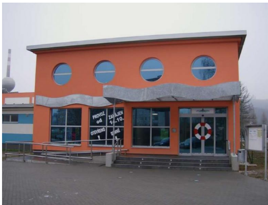
Obrázek 29 – Vstup do krytého bazénu v Zábřehu stav podzim 2017 [32]
