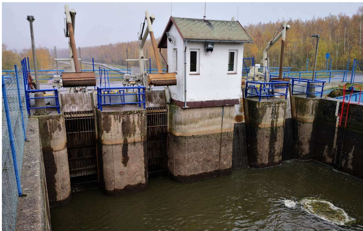
Obr.13 Vtokový objekt na Ervěnický koridor a MVE
