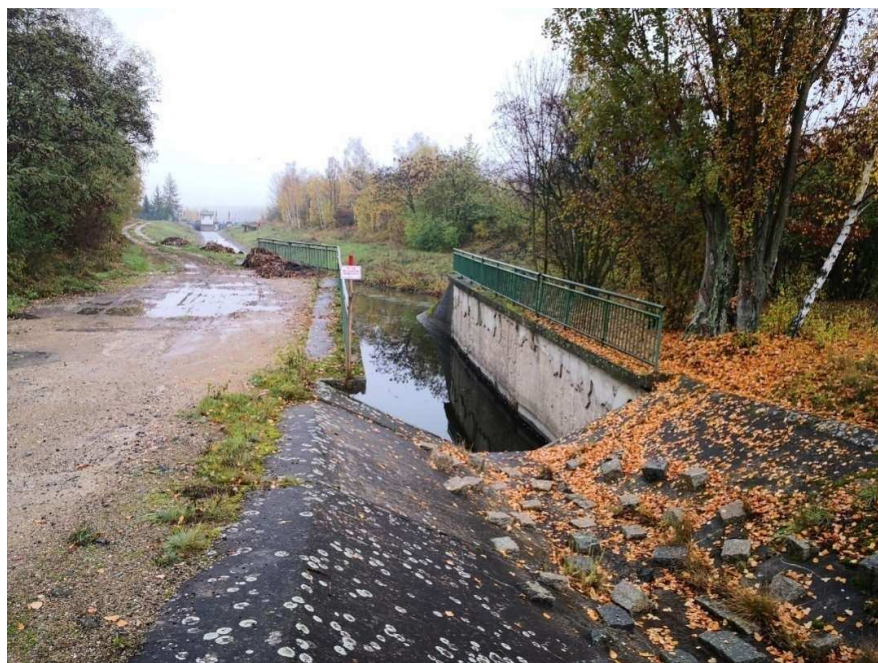
Obr.25 Soutok spojovacího koryta PKP do řeky Bíliny pod VD Újezd
