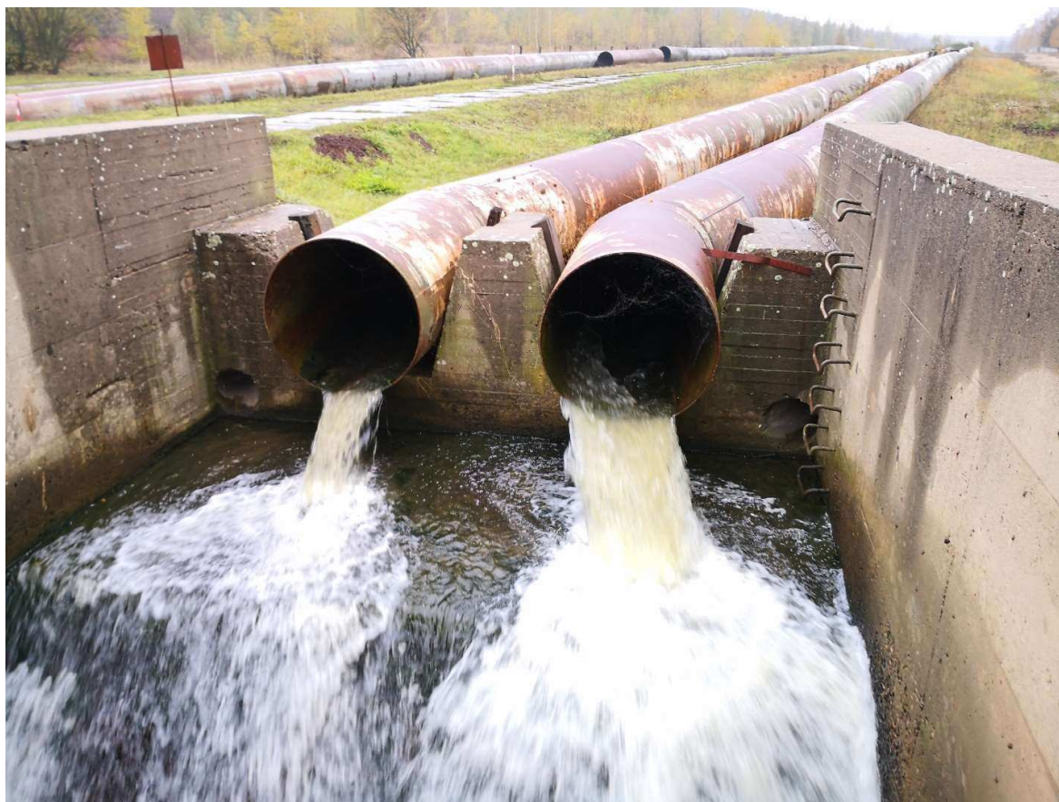
Obr.16 Výtokový objekt potrubí EK
