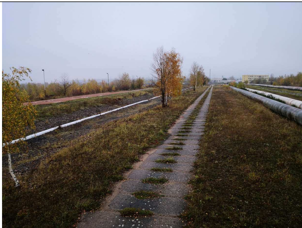
Obr.14 Nouzové koryto a potrubní vedení EK
