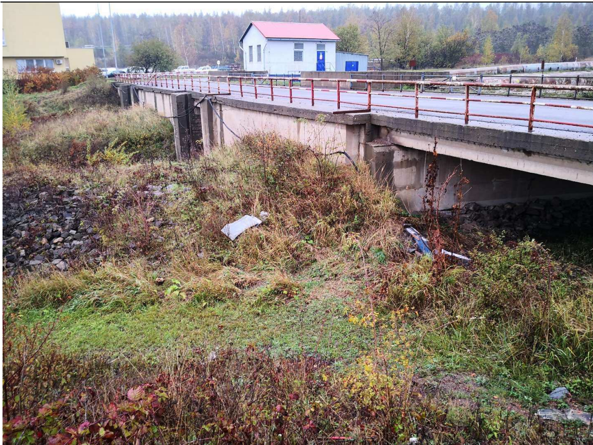
Obr.38 Stávající železobetonový most
