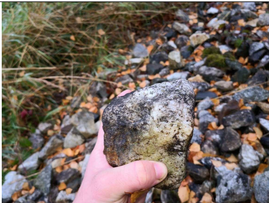
Obr.31 Kamenný pohoz stávajícího nouzového koryta z valounů
