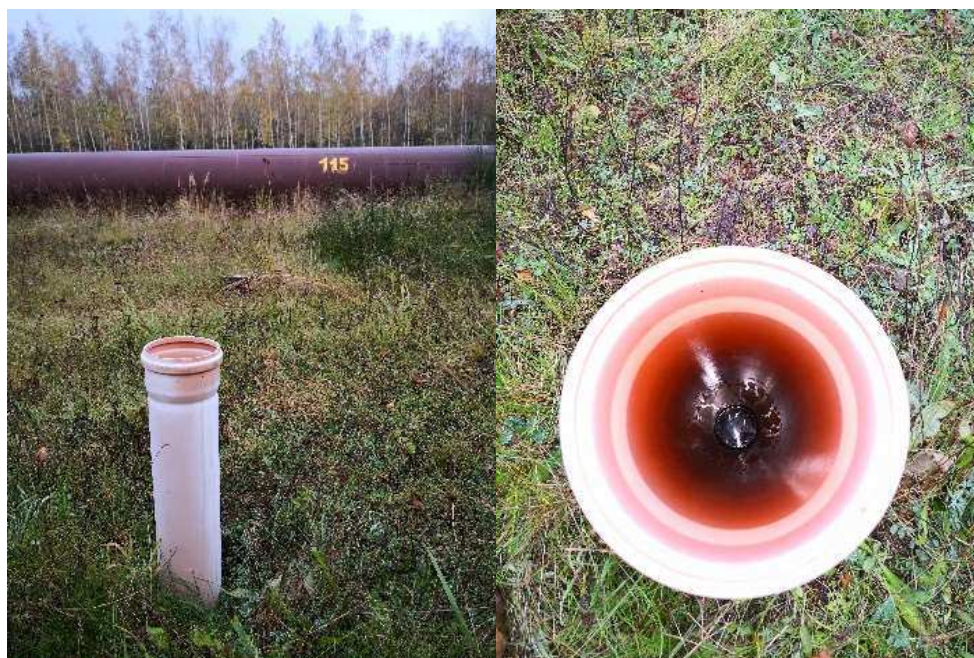
Obr.4 Pozorovací sonda vedle stávajícího potrubí
