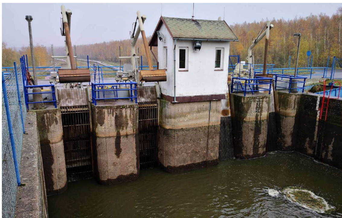
Obr. 13 Vtokový objekt na Ervěnický koridor a MVE
