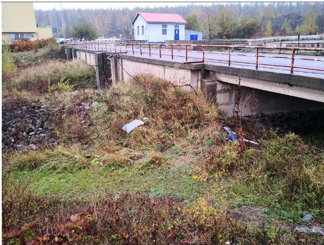
Obr.38 Stávající železobetonový most
