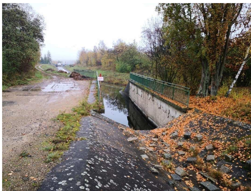
Obr.25 Soutok spojovacího koryta PKP do řeky Bíliny pod VD Újezd
