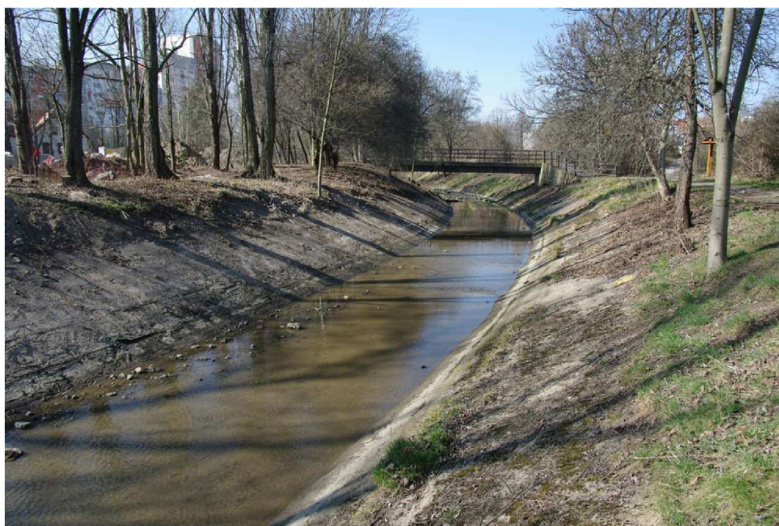
Obr.21 Vodní tok Rokytka s betonovým opevněním před provedením revitalizace [19]
