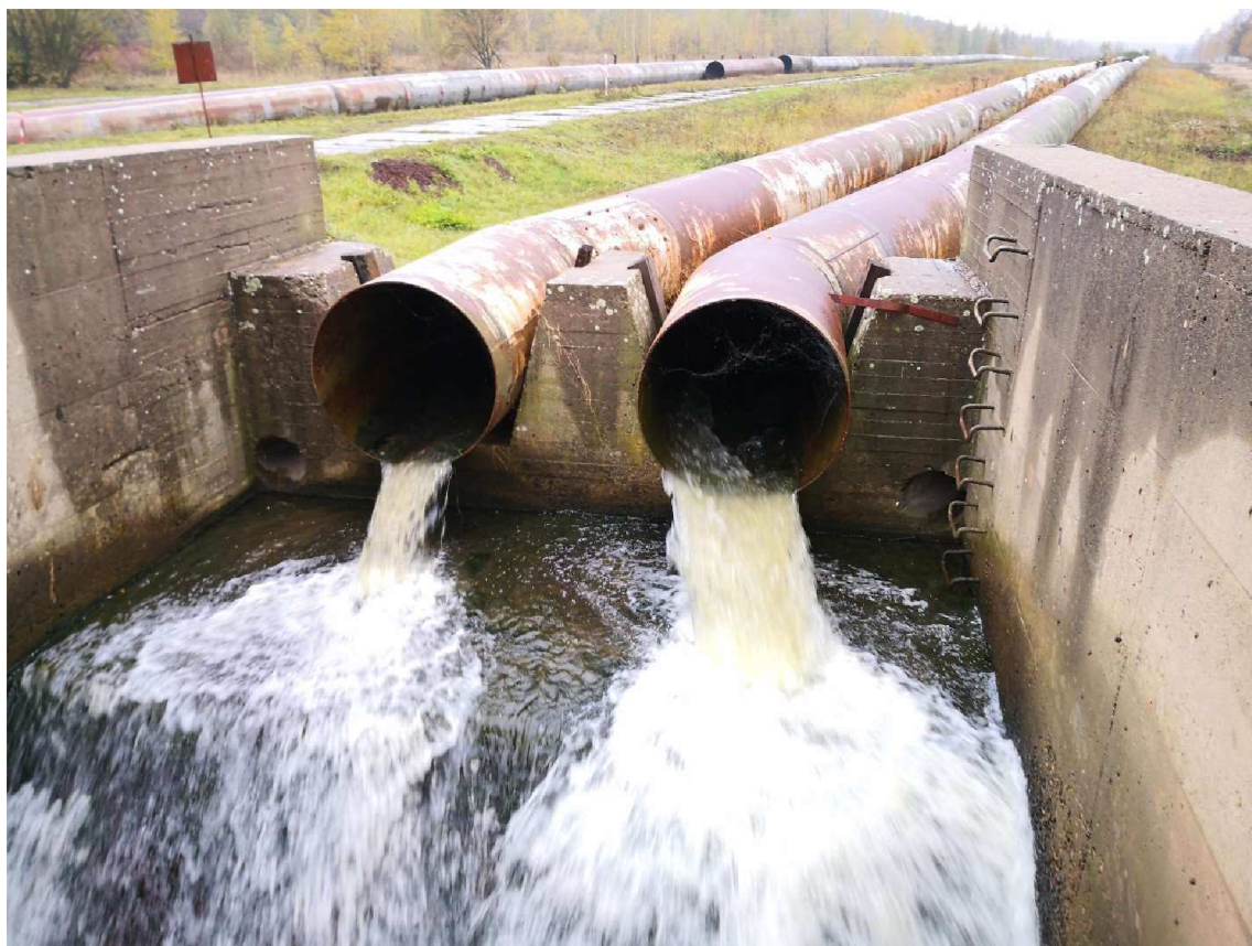
Obr. 16 Výtokový objekt potrubí EK
