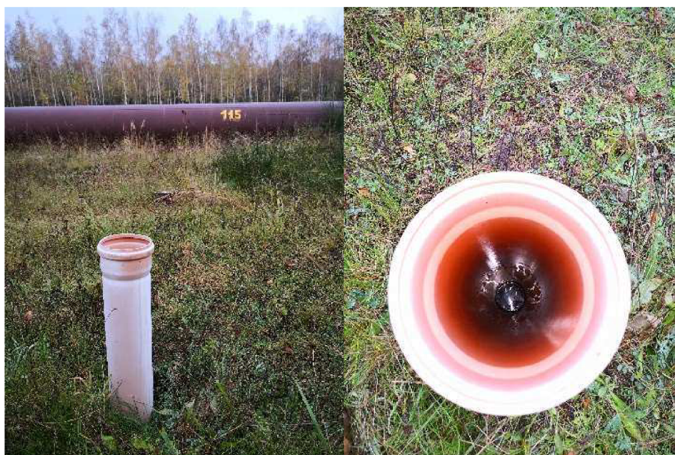
Obr.4 Pozorovací sonda vedle stávajícího potrubí
