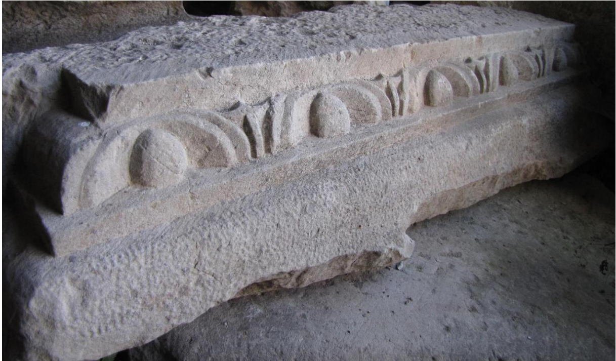
15. Boskovice – fragment profilované nadpražní římsy nebo dveřního ostění s vejcovcem, opuka, poslední čtvrtina 16. století
