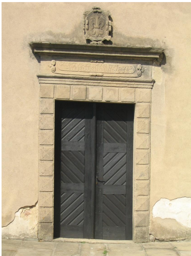
29. Buchlov – vstupní portál do tzv. tanečního sálu, pískovec, vystavěného roku 1602
